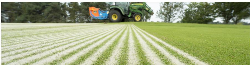
Fase 3: het loodrecht op de drains aanbrengen van zandsleuven
